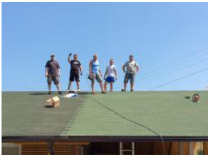
»Še malo, pa smo konec« – del ekipe zaključuje s krovskimi deli. Ostrešje smo skoraj v celoti naredili v lastni režiji, opravljenih je bilo skupno preko 600 prostovoljnih delovnih ur
