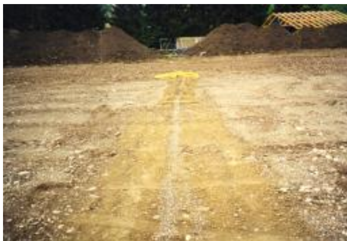
V bazni osnovi je bilo izvedeno tudi odvodnjavanje igrišča.
