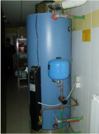
Slika 5: Plinski grelnik vode
