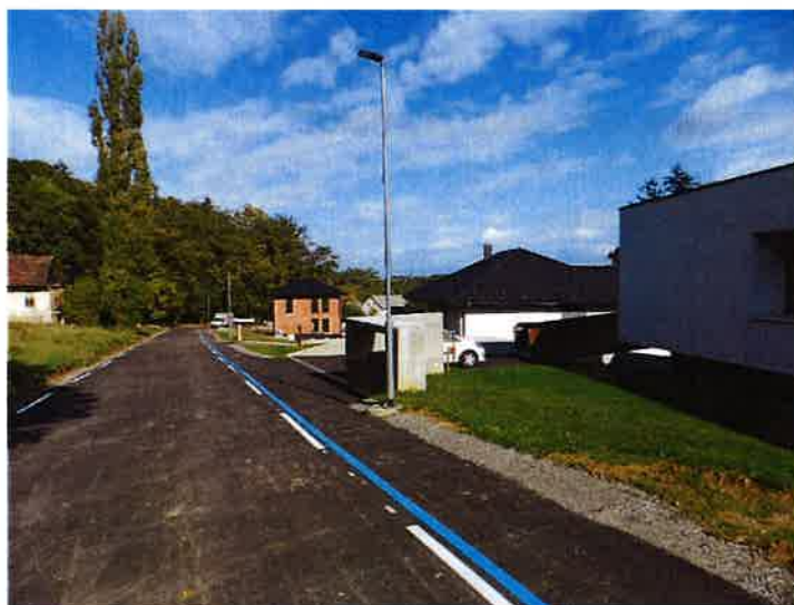
Slika 5: Asfaltiranje ceste JP 703 370
