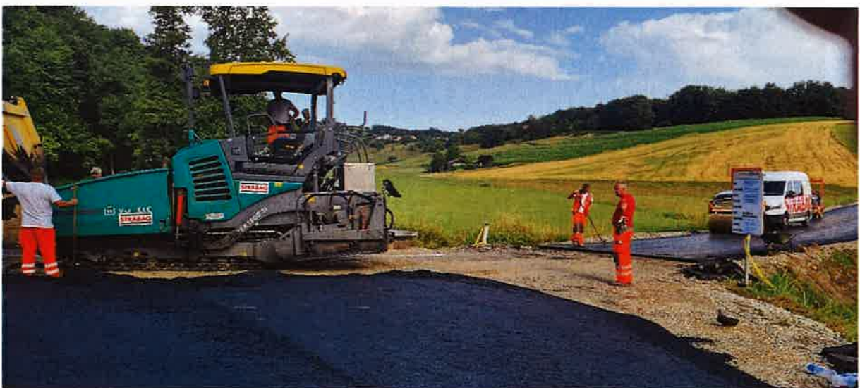
Slika 33: cestna dela na projektu Rekonstrukcija občinskih cest IV. faza
