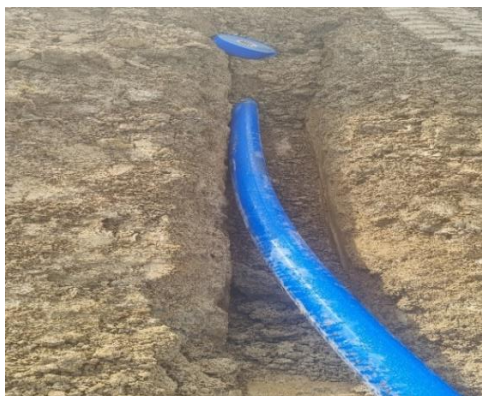
Slika 12: rekonstrukcija cevododa Lenart – Jurovski Dol
