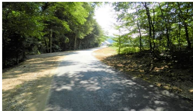
Slika 6: Izgradnja ceste JP 703 316
