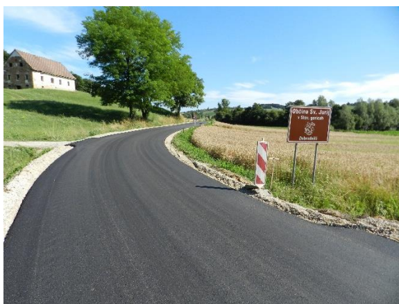
Slika 33: cestna dela na projektu Rekonstrukcija občinskih cest IV. faza
