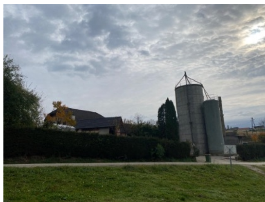
2 - Pogled z zahoda
