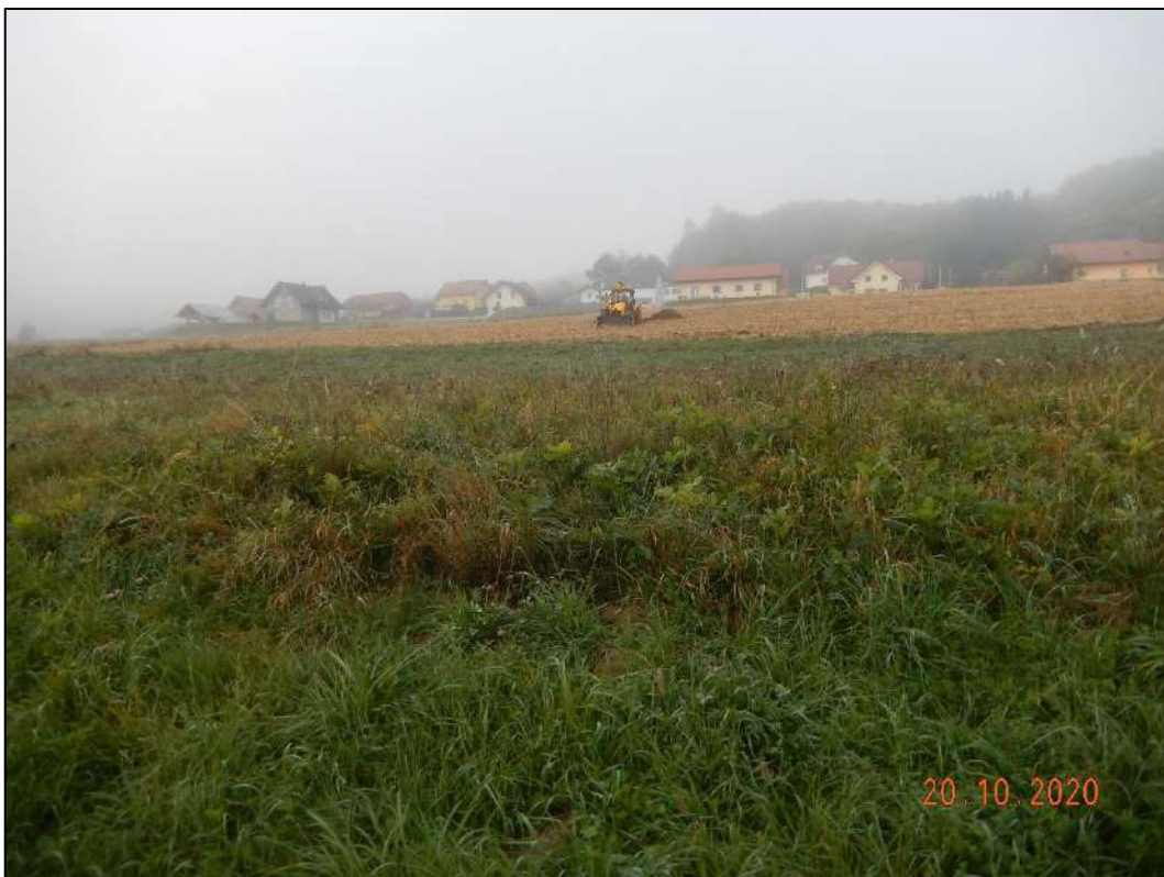
Območje gradnje – pogled od vzhoda (Foto: 20.10.2020)
