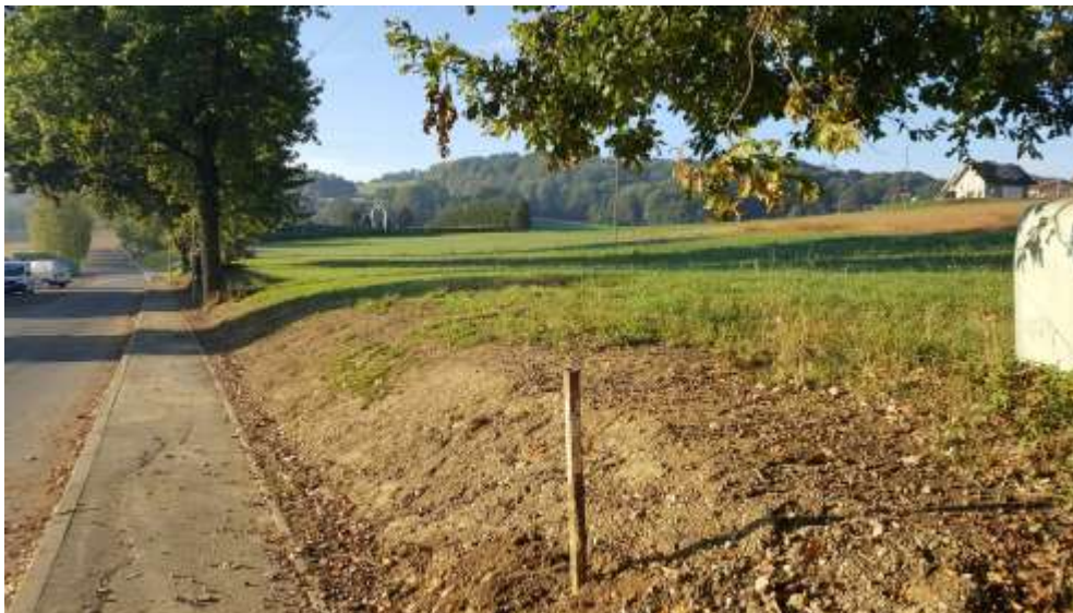
Slika 11: Pogled na obstoječe stanje, pogled na teren in traso nove dovozne ceste vir:Urbis d.o.o.
