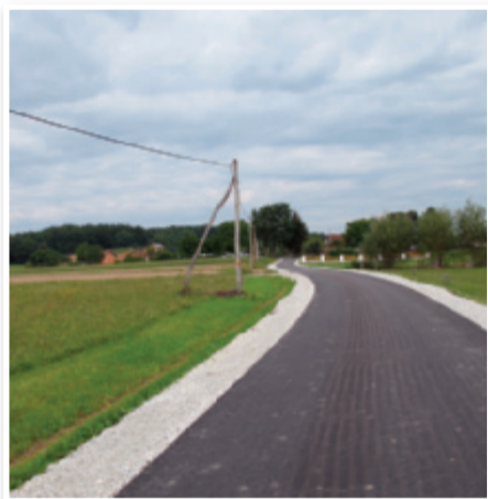
Rekonstruirana cesta je zares lepo urejena in kakovostno zgrajena
