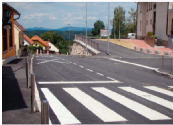
Prenovljeno vozišče ob šoli in cesta proti Cmureku z novimi pločniki (Foto: Primož Kocbek)
