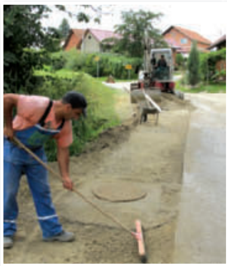
Po razširitvi čistilne naprave in izgradnji kanalizacije za več kot 30 gospodinjstev so vse ceste, ki so jih ob izgradnji kanalizacije poškodovali, spravili v prvotno stanje
