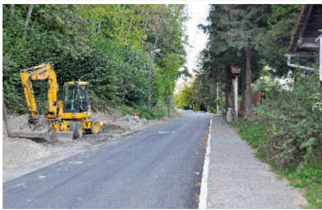
Prva preplastitev ceste v naselju Lokavec
