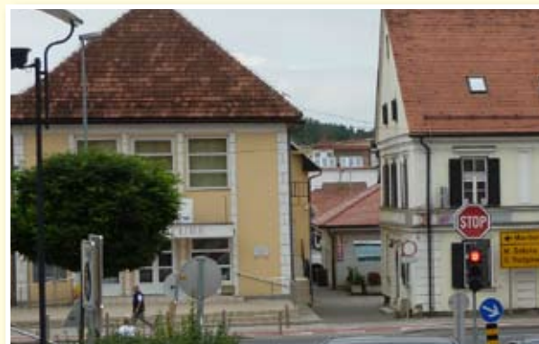
○ Konec novembra 2010 je občina Lenart začela s celovito rekonstrukcijo Kulturnega doma Lenart, ki naj bi se zaključila v avgustu letos.
