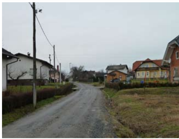
Slovenska ulica čaka na ponovno preplastitev z asfaltom
