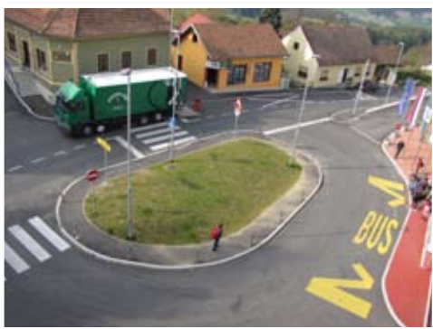
Lani zgrajeno krožišče pred osnovno šolo
