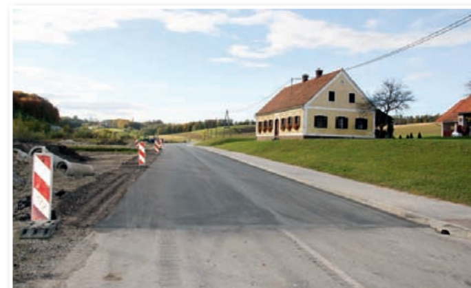
Pogled na del na novo asfaltirane ceste pri Zelenikovi domačiji v Cogetincih
