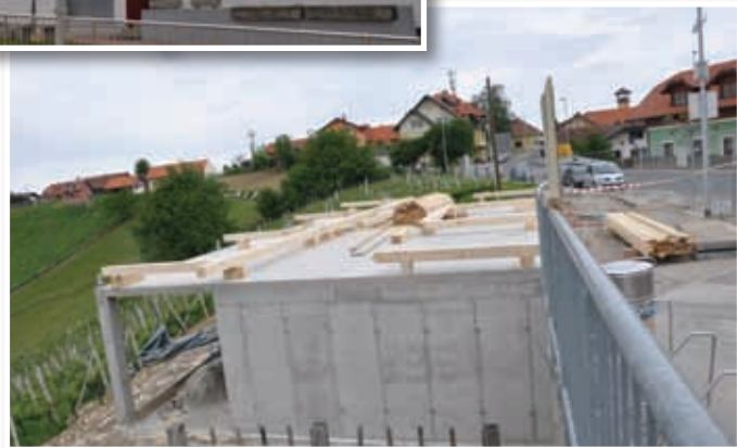
Gradnja razgledne ploščadi
