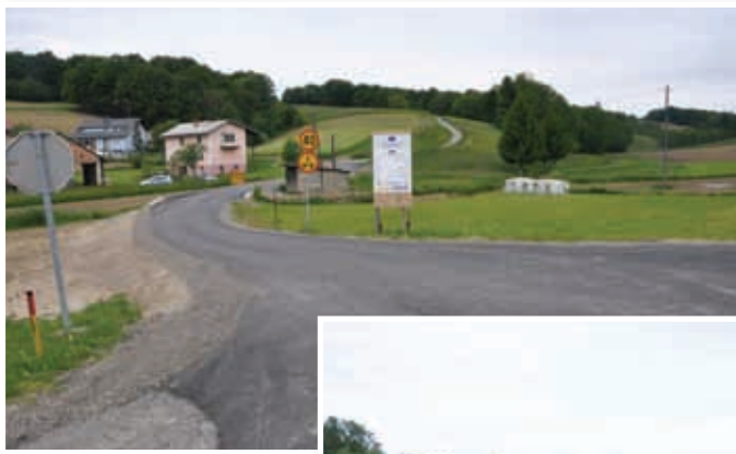
Asfaltiranje ceste v Ledineku
