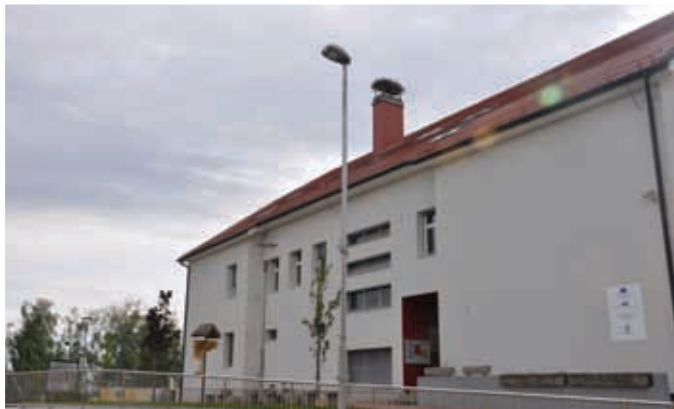
Dokončana šolska streha
