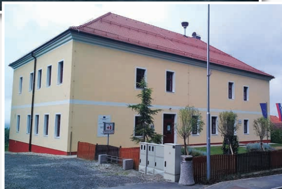
Obnovljeno poslopje osnovne šole v Lokavcu
