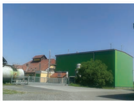
Bioenergetski kompleks Cmurek
