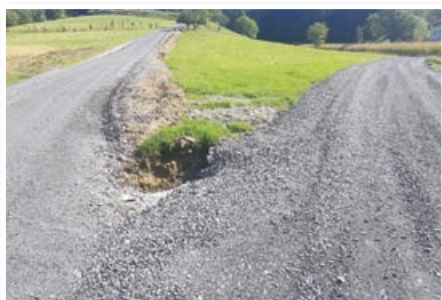
Obnova ceste Kremberk-Kolman
