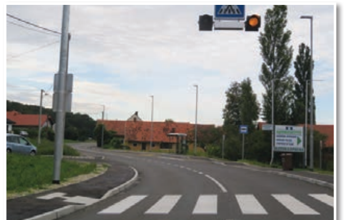
Modernizacija ceste skozi Gočovo je povečala varnost v cestnem prometu.
