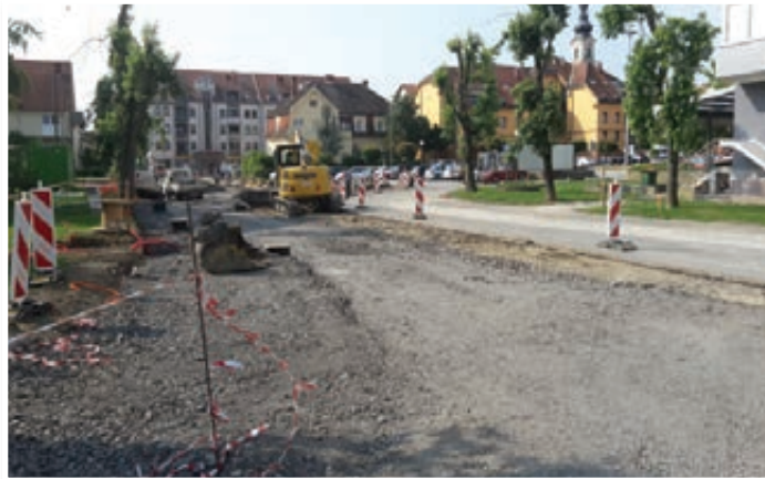
Ena od faz gradnje krožišča pri pošti
