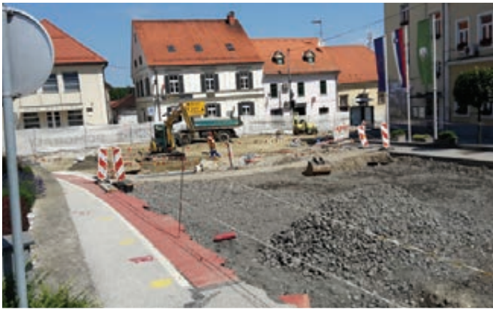
Med gradnjo krožišča na osrednjem lenarškem trgu
