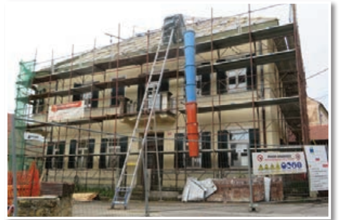
V središču Svete Trojice izvajajo celovito energetske sanacije in prenovno znamenitega poslovnega objekta, ki daje značilno veduto kraja.
