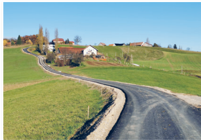
Nova asfaltna cesta čez Sp. in Zg. Partinje
