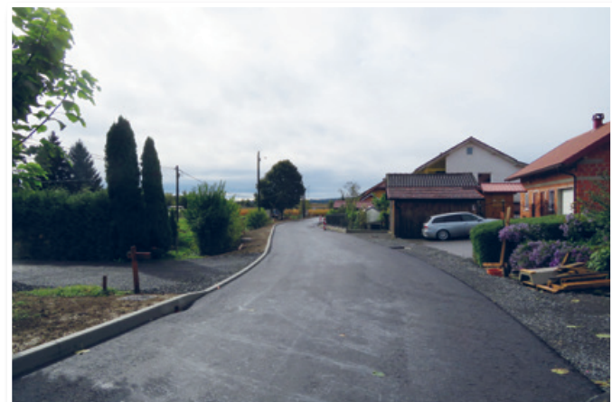
Ob rekonstrukciji ceste Zgornja Senarska–Vas so uredili tudi vso komunalno infrastrukturo.
