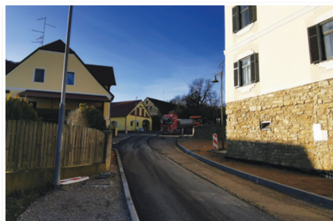
Asfaltiranje državne ceste čez Jurovski Dol
