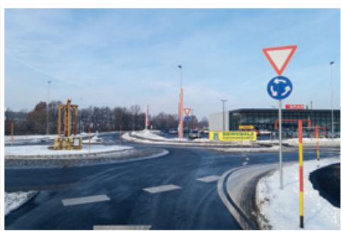
Nova dovozna cesta v NPIC
