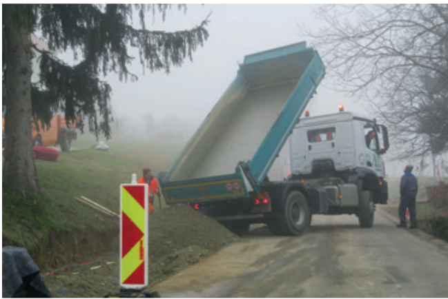
V Občini Cerkevjak so na začetku decembra intenzivno gradili nov pločnik ob odseku ceste Cerkevjak-Vitomarci od Tušakove vile do odcepa za Stanetinca in Andrenca. Nov pločnik bo povečal varnost pešcev, med katerimi je največ šolarjev.
