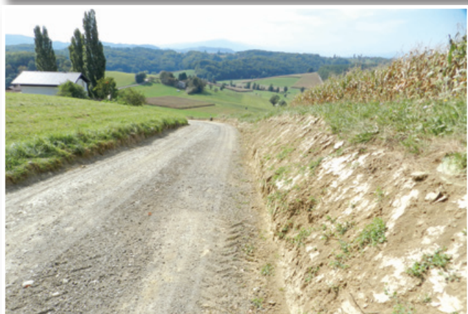
Gradbena dela na cesti v Zg. Partinju, ki potekajo v sklopu IV. faze rekonstrukcije občinskih cest, se nadaljujejo.
