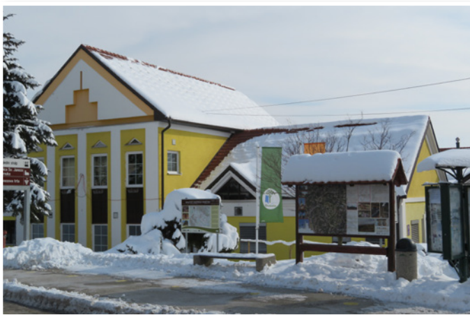
Po energetske prenovi bo poslopje osnovne šole v Cerkevniku dobilo novo podobo, ki bo polepšala središče Cerkevnika. Foto: T. Kšela
