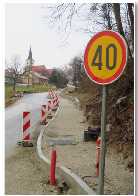
Novi pločnik in javno razsvetlavo od Tušakovih vil v Cerkevniku do odcepa za Stanetince in Andrence so gradili konec lanskega leta. Foto: T. Kšela
