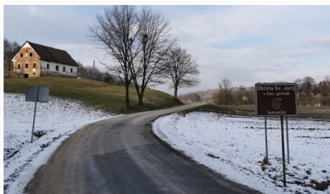
Rekonstrukcija ceste na meji od občine Lenart do križišča v Zg. Partinju se bo pričela v prihodnjem mesecu. Foto: Dejan Kramberger
