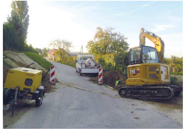
Ob gradnji optičnega omrežja in pri polaganju električnih kablov pod zemljo morajo večkrat cesto »prebiti« pod asfaltom s tako imenovanimi »raketami«.
