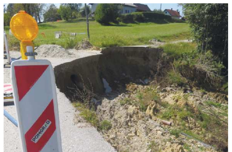
Plaz, ki se je po obilnem deževju sprožil na meji med občino Cerkvjenjak in Sveto Trojico, resno ovira promet in ogroža prometno varnost.
